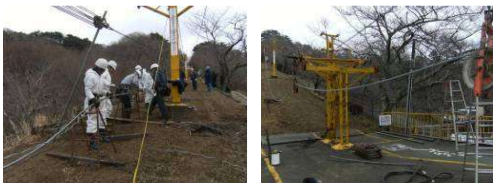
リフトロープの更新工事の様子
