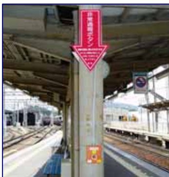
非常通報ボタン
