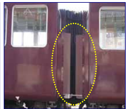
連結面間の転落防護柵
