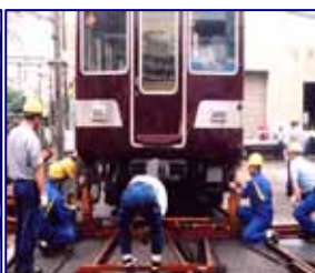
列車の脱線復旧
