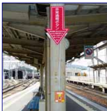
非常通報ボタン
