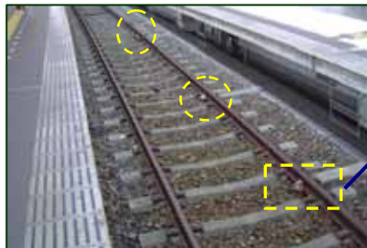
終端防護装置 (点線で囲んだ部分が速度照査点)
