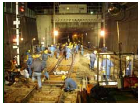
日生線、線路分岐器更新工事
