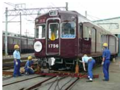
列車の脱線復旧
