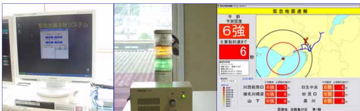
緊急地震速報システム
