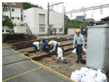
破損した枕木の交換
