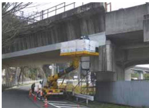
コンクリート剥落防止措置
