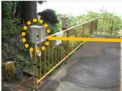
乗降場に設置の非常停止ボタン（異常発生時に係員が操作します）
