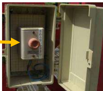
乗降場に設置の非常停止ボタン（異常発生時に係員が操作します）
