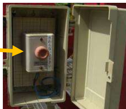
乗降場に設置の非常停止ボタン（異常発生時に係員が操作します）
