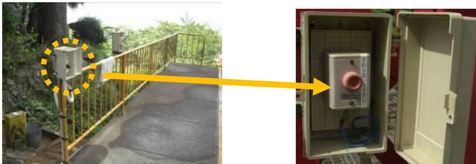
乗降場に設置の非常停止ボタン（異常発生時に係員が操作します）
