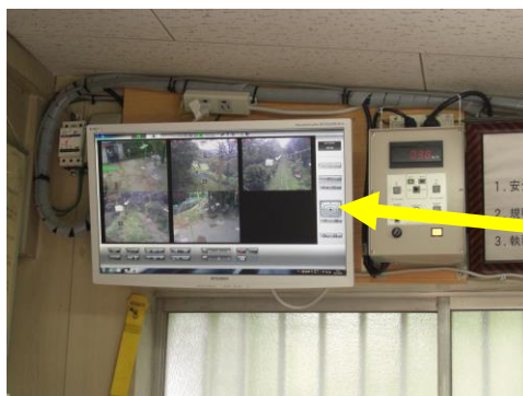
ふれあい広場駅の搬器監視装置及び風速監視装置
