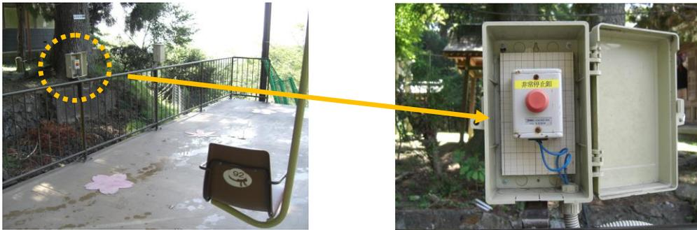
リフト各駅に設置の非常停止ボタン（異常発生時に係員が操作します）
