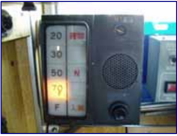
運転台の A T S 表示器 (制御速度等を表示)
