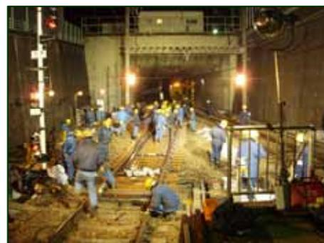
日生線、線路分岐器更新工事
