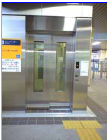
平野駅エレベーター
