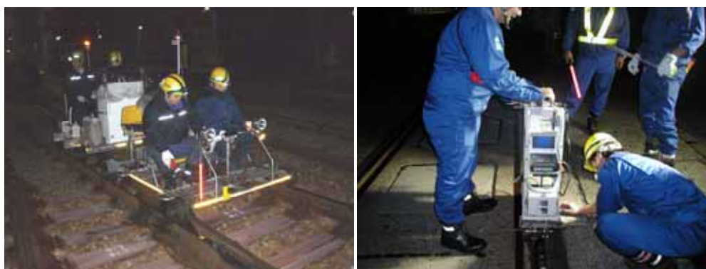
超音波レール探傷器による検査
