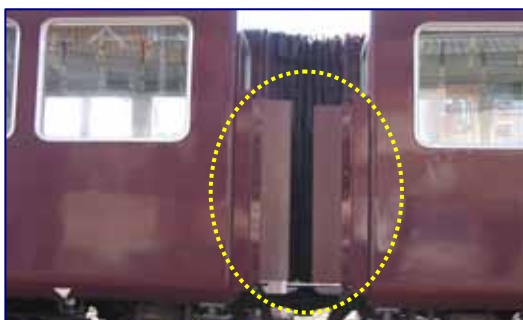
連結面間の転落防護柵
