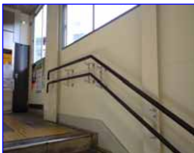
２段式階段手すり
