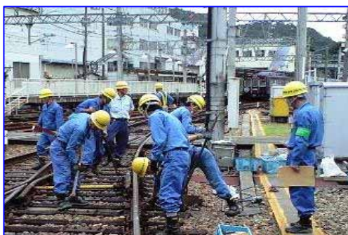
レール補修作業
