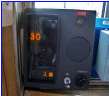
運転台のA T S 表示器 (制御速度等を表示)
