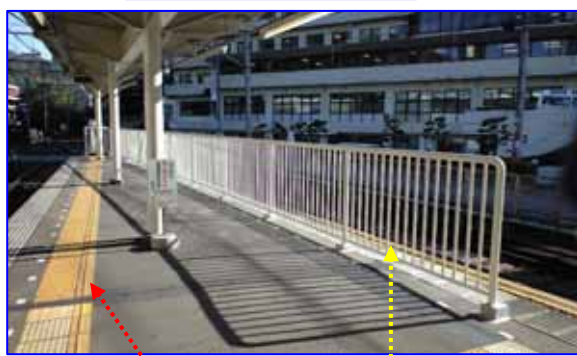
誘導タイルと内方線
