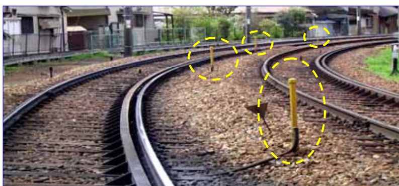
限界支障報知装置 (点線で囲んだ部分が検知柱)
