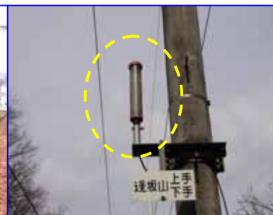
落石検知装置用 特殊信号発行機
