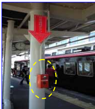
非常通報ボタン
