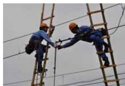
断線した架線の修復
