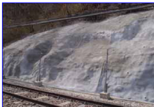
光風台～ときわ台駅間の法面補強 (逢坂山曲線付近)
