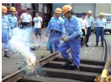
破損したレールの修復
