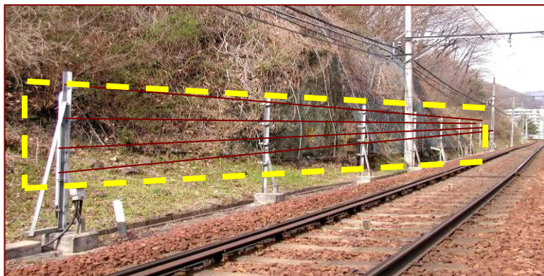
落石検知装置 (点線で囲んだ部分が検知線)
