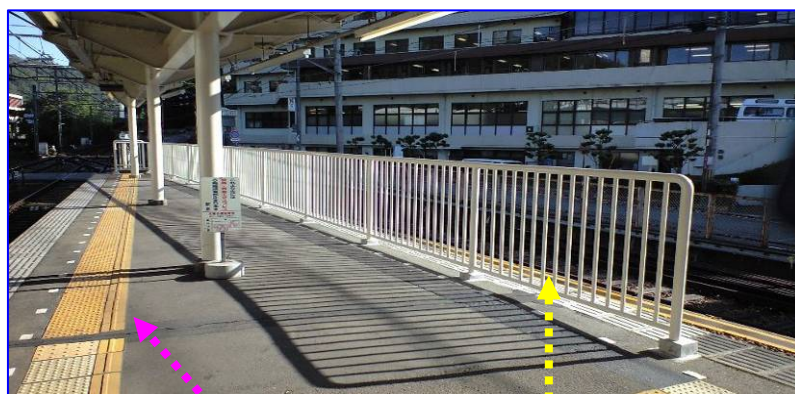
誘導タイルと内方線
