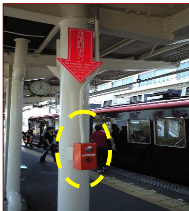
非常通報ボタン
