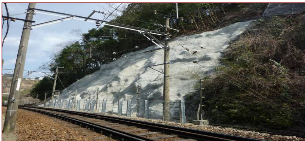
光風台～笹部駅間の法面補強 (西口曲線付近)
