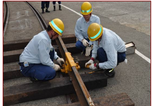
破損したレールの修復
