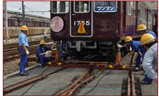
列車の脱線復旧
