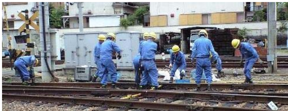
軌道補修作業
