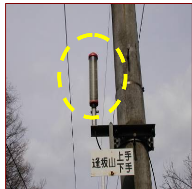
落石検知装置用 特殊信号発行機
