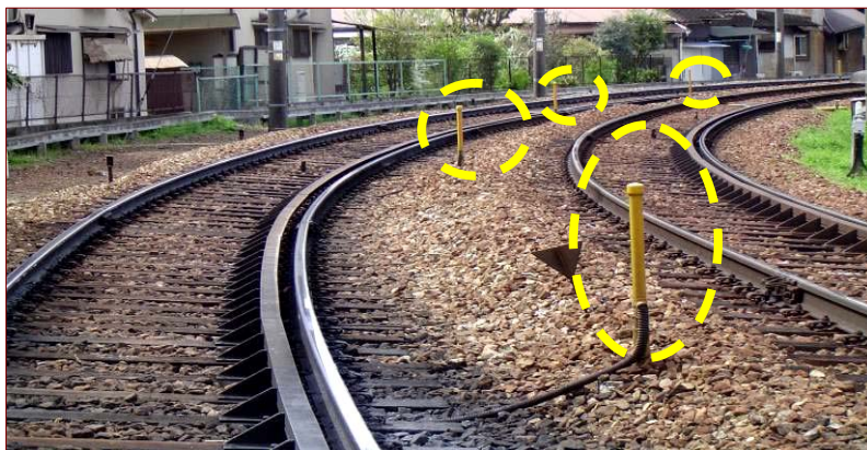
限界支障報知装置 (点線で囲んだ部分が検知柱)
