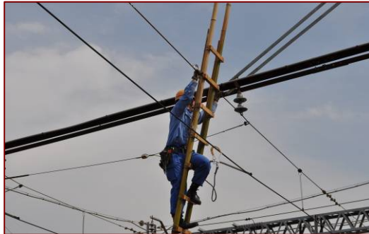
断線した架線の修復
