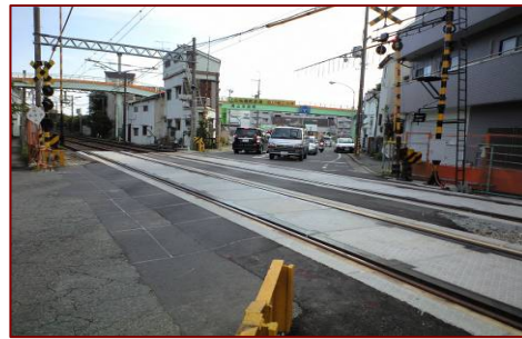
樋ノ口踏切道 歩道整備工事
