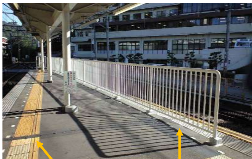
誘導タイルと内方線
