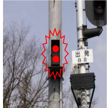
転落支障報知装置用 アクシデントサイン (写真は動作イメージ)
