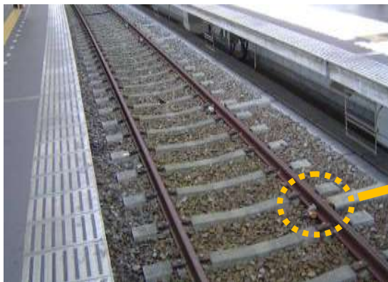
終端防護装置 (点線で囲んだ部分が速度照査点)
