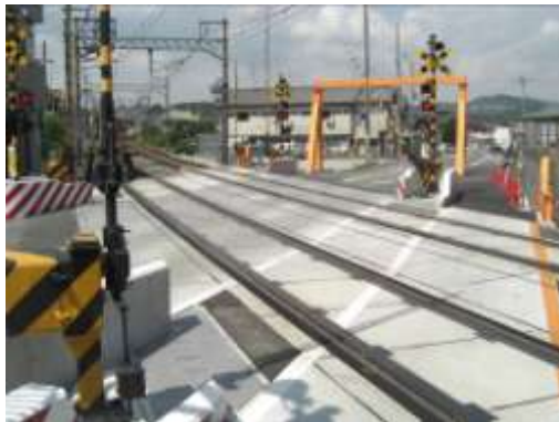
完成した樋ノ口踏切道 歩道整備工事
