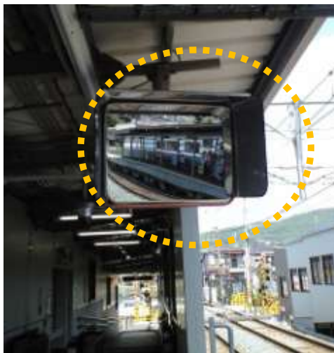
ワンマン運転用のホームミラーとモニター
