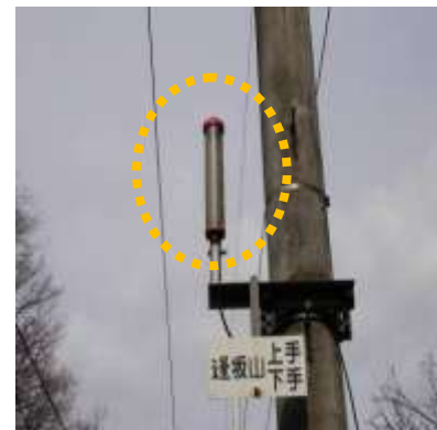
落石検知装置用 特殊信号発行機
