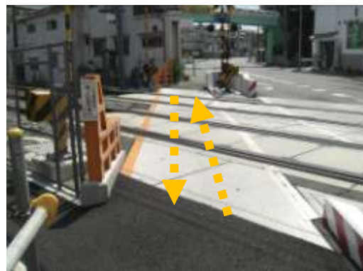
樋ノ口踏切道 歩行者専用踏切
