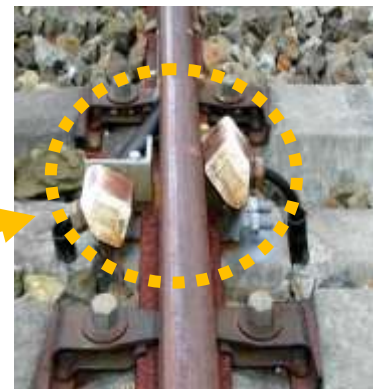
終端防護装置 (点線で囲んだ部分が速度照査点)
