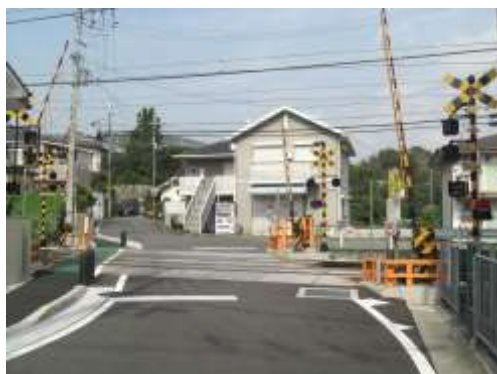
完成した上平野踏切道 歩道整備工事
