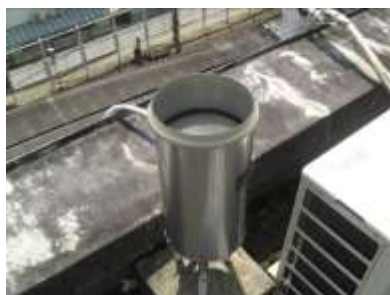
平野駅に設置されている雨量計
