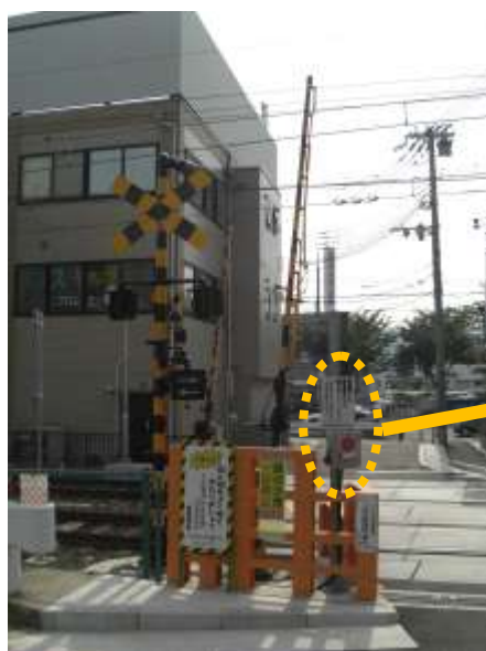
上平野踏切道 踏切非常通報装置
