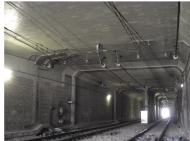
上部コンクリート補強工事中の日生トンネル内部
