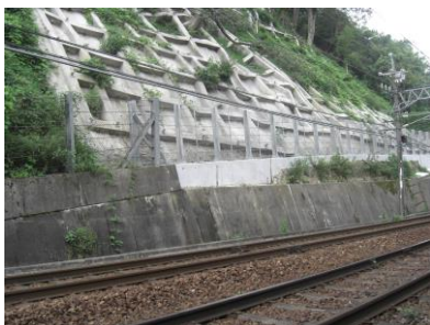
一の鳥居駅～畦野トンネル間下り線側
