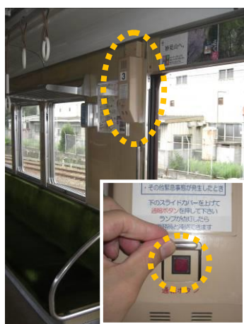
客室内の非常通報装置 (1500、1700、3100 系)
