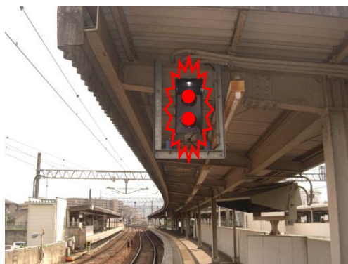
アクシデントサインが動作し、乗務員に知らせる。(動作イメージ)
