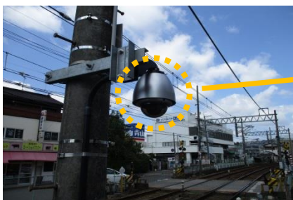
踏切監視カメラ
