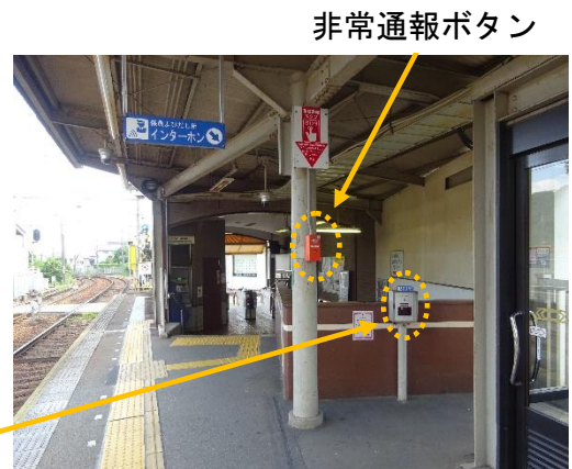
係員呼び出し用インターホン
